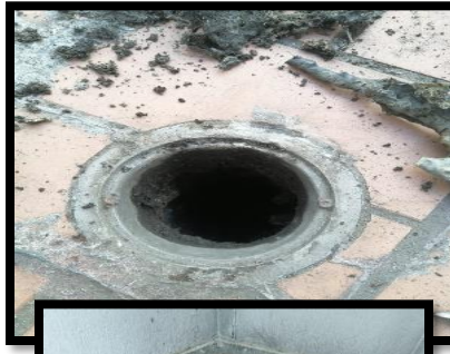
17. Destaponamiento de tubo por rebose de agua frente a torre 1 y 3
