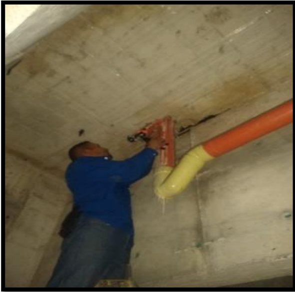
15. Se realiza arreglos de gotera parqueadero 056
